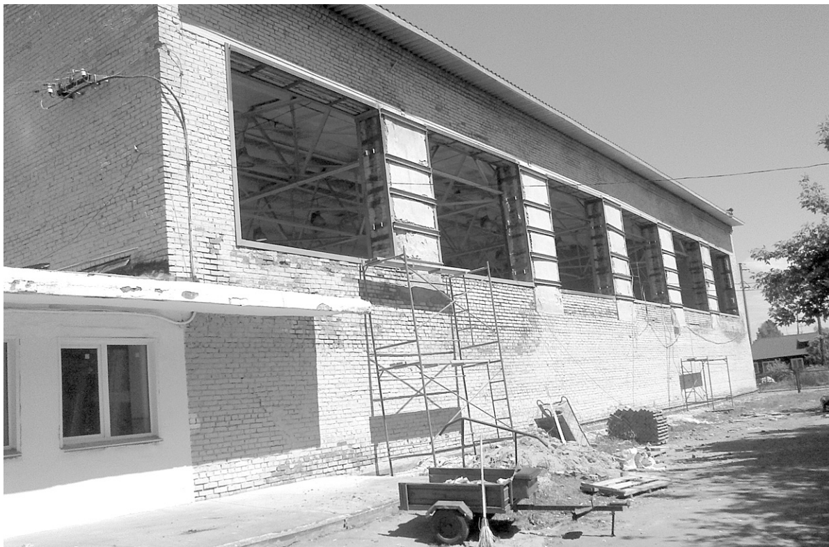
Коченёвская ДЮСШ, усиление наружных кирпичных стен и оконных проёмов стальными обоями.
