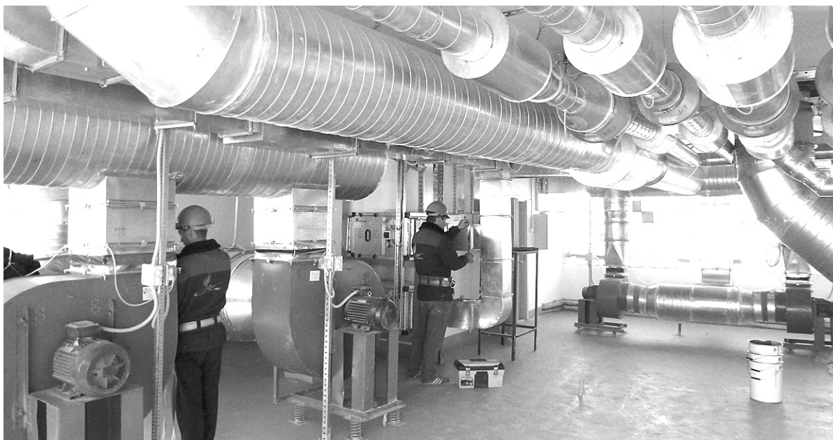
Оборудование, которое монтирует и запускает компания «АртКлимат», выглядит футуристично.
