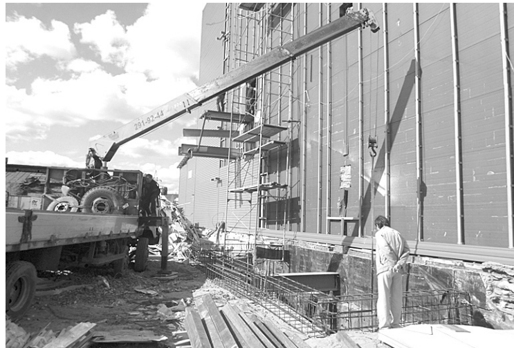
Параллельно с отделкой завершаются работы на инженерных сетях.
