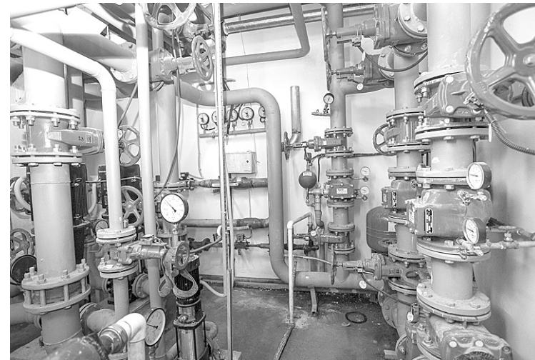
Так выглядит современная система водоснабжения.
